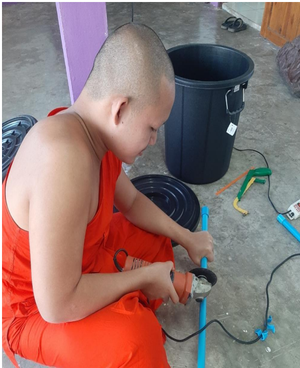
ภาพที่ 3 กำลังตัดท่อพีวีซี และเจาะรูระบายน้ำ
