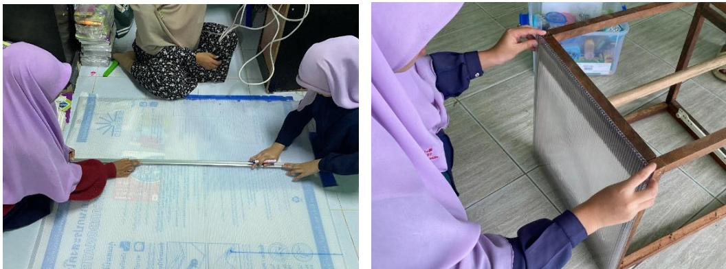
ภาพที่ 3.5 ใส่รางลื่นซี่กรับข้างด้านล่างทั้ง 2 ด้าน ตัดและประกอบแผ่นโพลีคาร์บอเนตรอบด้าน
