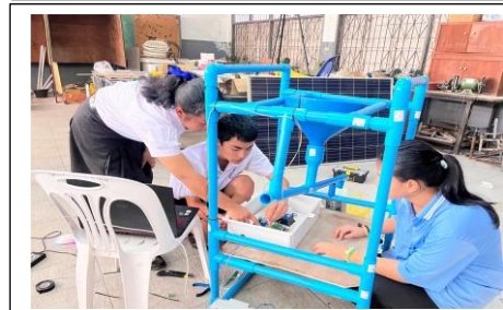
รูปภาพที่ 12 แสดงภาพโครงสร้าง เครื่องให้อาหารปลาอัจฉริยะด้วยพลังงานแสงอาทิตย์
