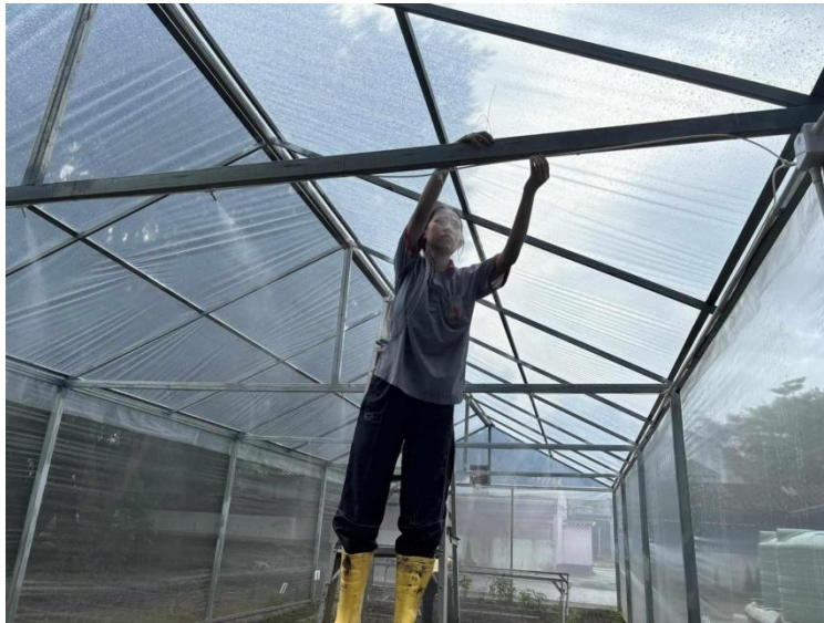
รูปที่ 2 ติดตั้งระบบภายในโรงเรือน
