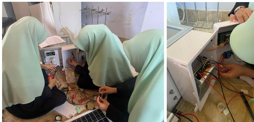
รูปภาพที่ ๓.๔ รูปภาพแสดงการติดตั้งระบบ
