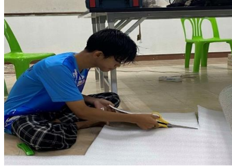
ภาพที่ 3.6 วัดขนาดแผ่นอะลูมิเนียม ฉนวนกันความร้อน PE และตัดตามโครงสร้าง
