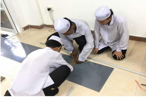
ภาพที่ 3.6 วัดขนาดแผ่นอะลูมิเนียม ฉนวนกันความร้อน PE และตัดตามโครงสร้าง
