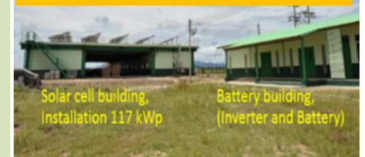
เฟส 1 ติดตั้งบนหลังคาอาคาร
